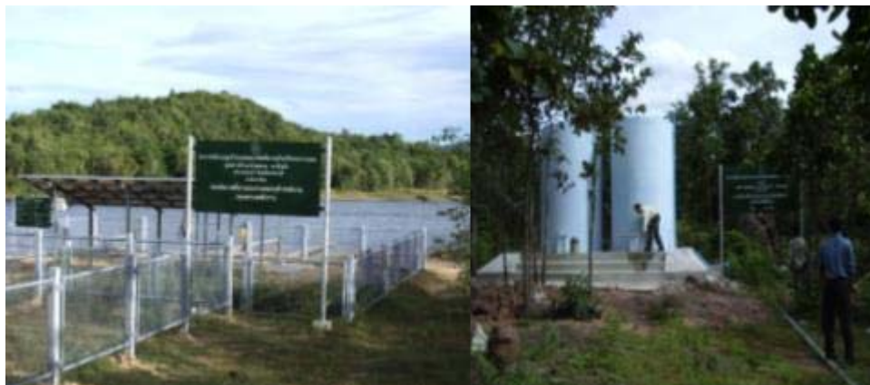
รูประบบสูบน้ำพลังงานแสงอาทิตย์และถังเก็บน้ำ
