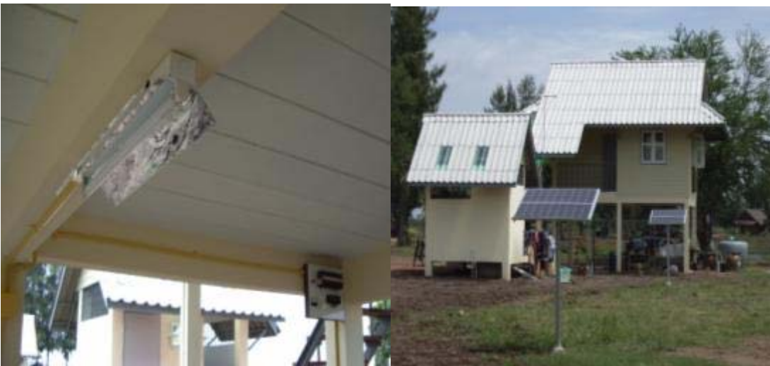
รูปแบบของระบบระบบผลิตไฟฟ้าด้วยเซลล์แสงอาทิตย์เพื่อแสงสว่างในครัวเรือน
