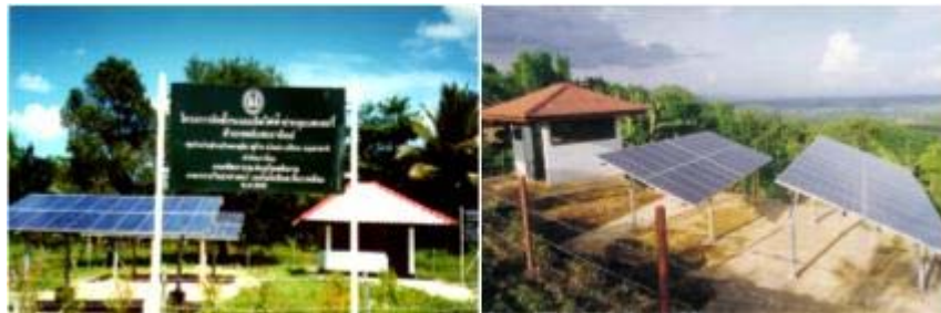
ระบบผลิตไฟฟ้าประจุแบตเตอรี่ด้วยเซลล์แสงอาทิตย์สำหรับหมู่บ้านชนบทที่ไม่มีไฟฟ้า
